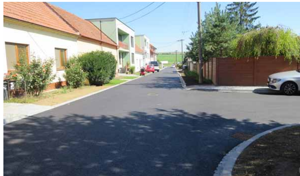
Rekonstrukce komunikace ul. Za Kovárnou, Sady
