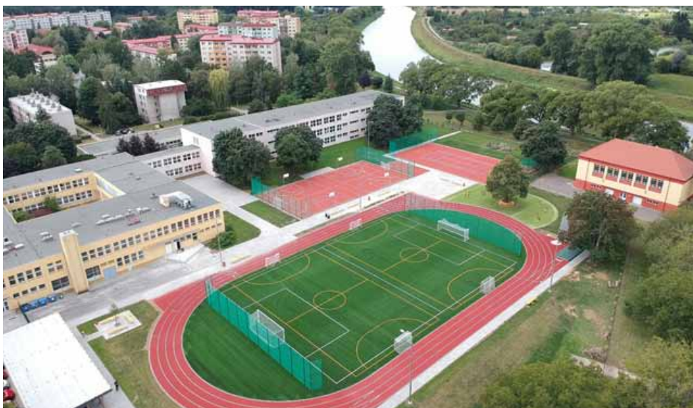
Rekonstrukce sportovního areálu Mojmír
