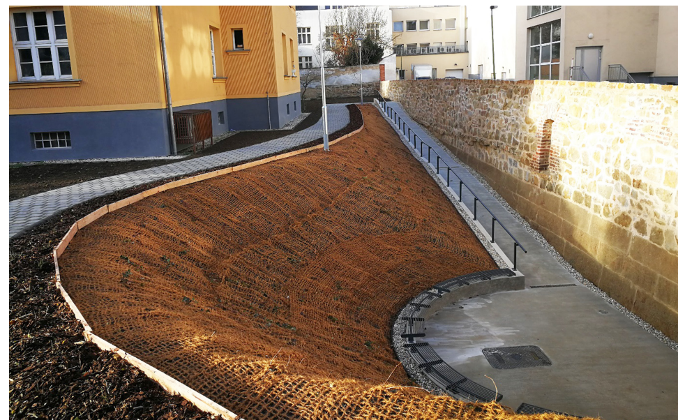
Obnova části městských hradeb ul. Hradební – Kollárova
