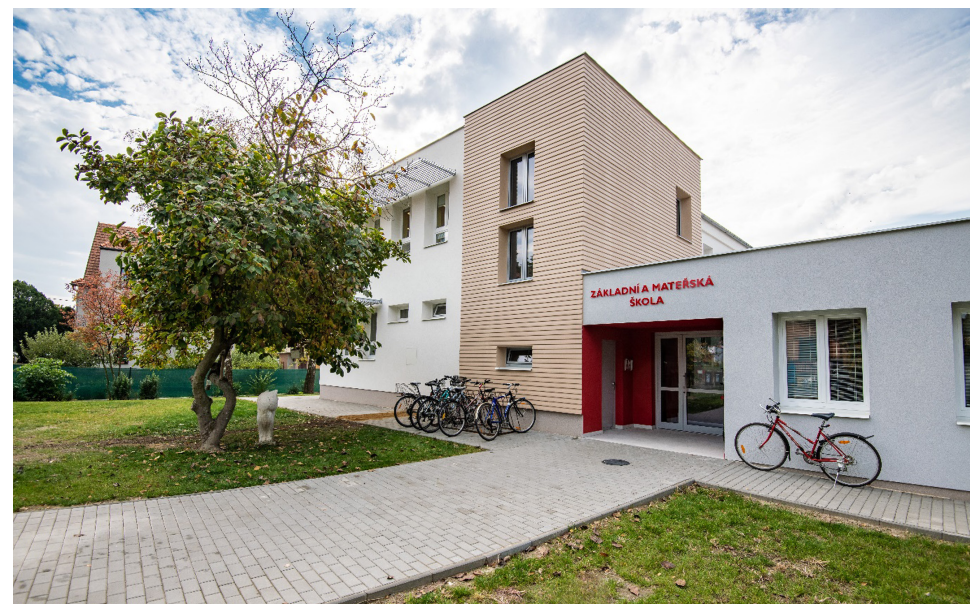
Stavební úpravy MŠ, ZŠ Šafaříkova
